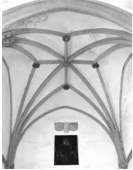
Fig. 6: Bóveda estrellada en el presbiterio de San Francisco (principios del siglo XVI)
