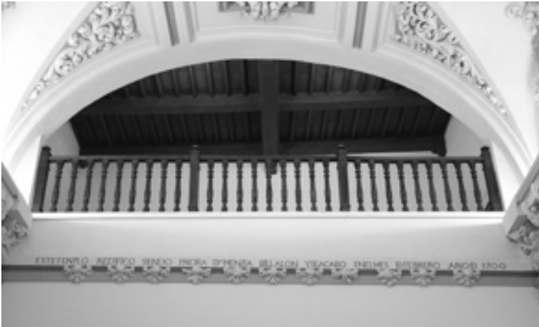
Fig. 7: Las bóvedas de yeso ocultaron en el XVIII los artesonados de madera quientistas. Cubierta de la iglesia de Madre de Dios
