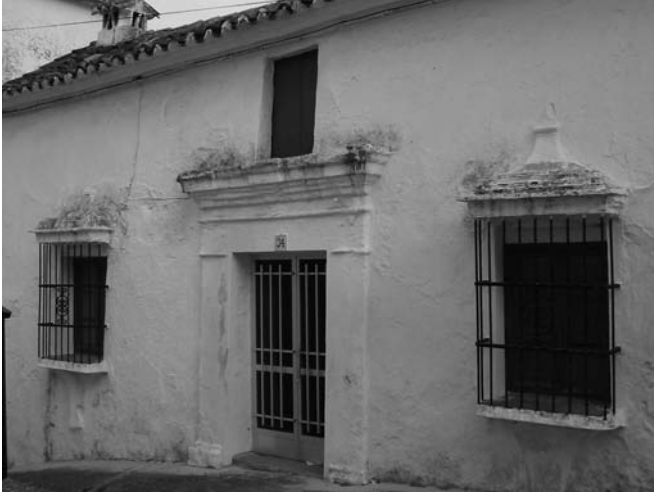
7. Vivienda en calle Fuerte nº. 34 (foto F. Márquez)
